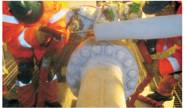
La aplicación a partir de ambos lados de grandes bridas agiliza la operación y contribuye a una calidad superior de recubrimiento
